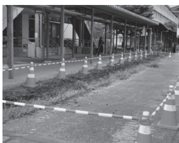
自転車置き場工事(練進館前通路北側)
