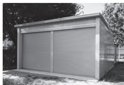
図書仮保管倉庫
