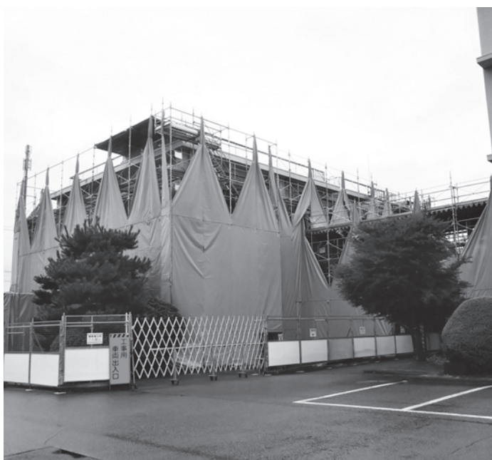
改築工事中の桜ヶ丘会館(図書館)
